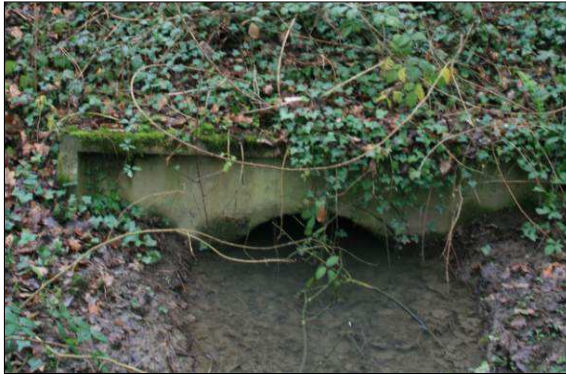
Figure 22 : Vue de la buse existante (source ARCADIS)
